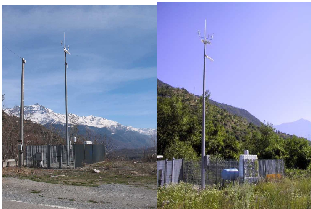
Figura 23: Fotografie della stazione di Finiere (ARPA Piemonte)
