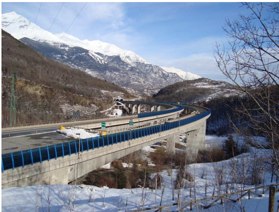
Figura 1: Vista dell'area che ospiterà il cantiere
