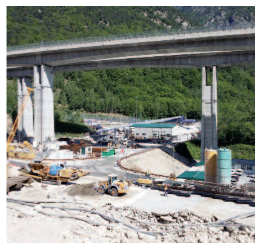
Il cantiere oggi
