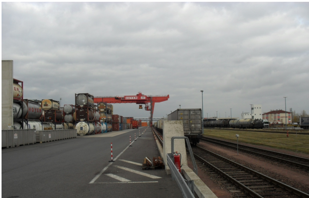
Figura 6 – Particolare dei binari per la movimentazione dei materiali
