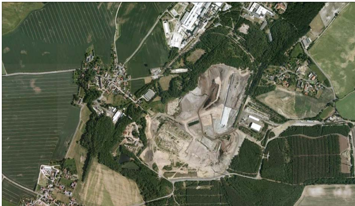
Figura 7 – Foto aerea dell'impianto
