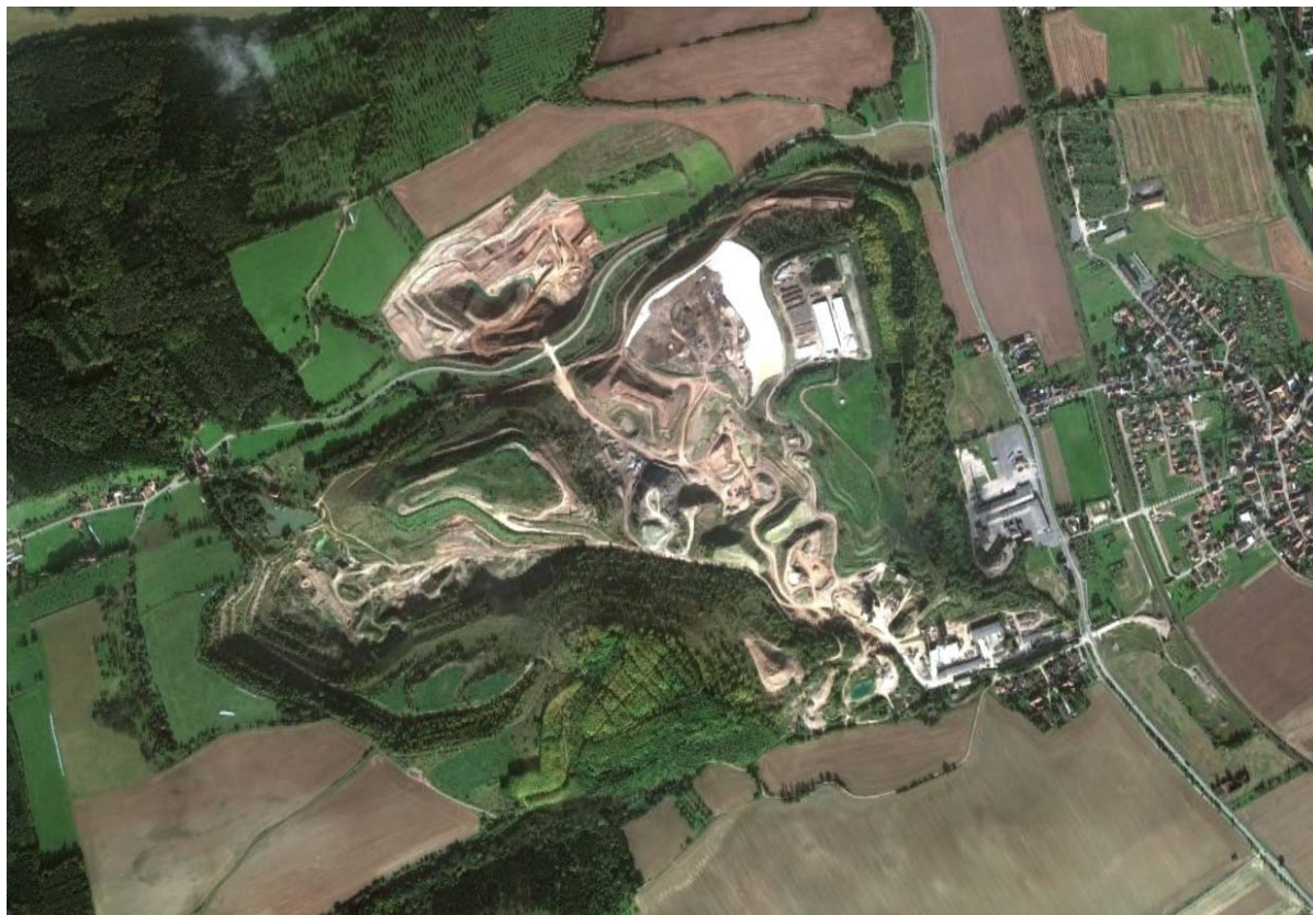
Figura 13 – Foto aerea dell'impianto
