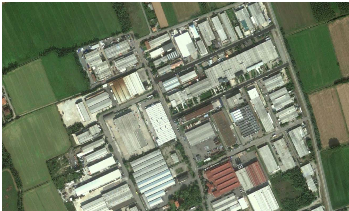
Figura 22 – Foto aerea dell'impianto
