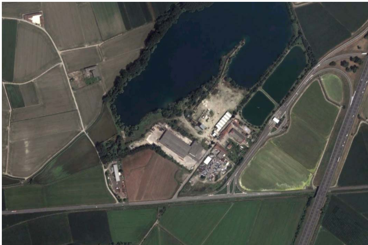
Figura 21 – Foto aerea dell'impianto
