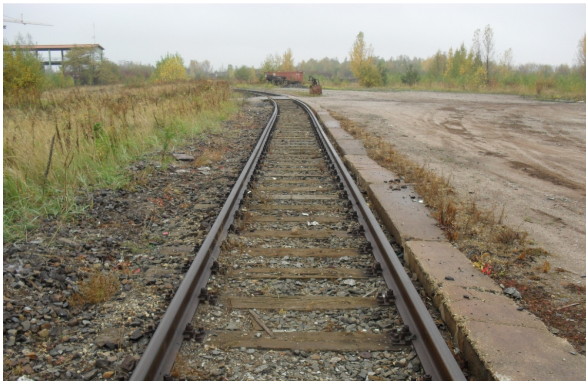
Figura 3 – Particolare dei binari per la movimentazione dei materiali
