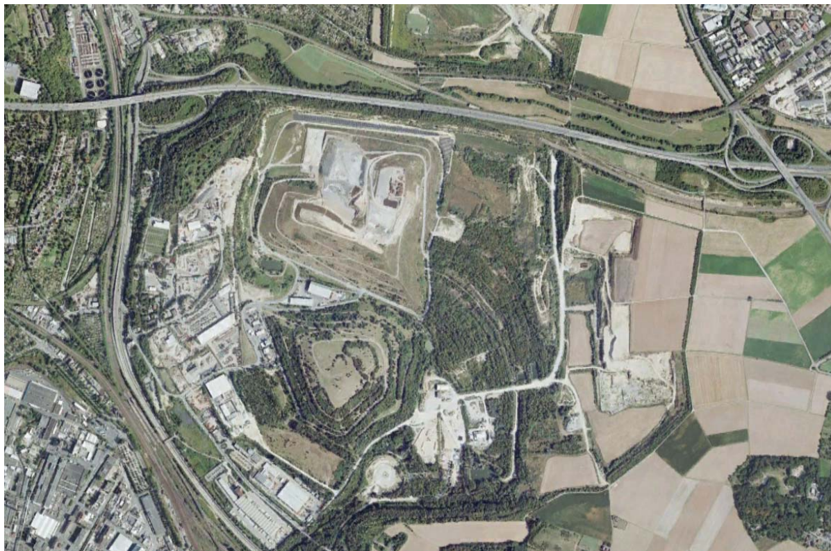
Figura 19 – Foto aerea dell'impianto
