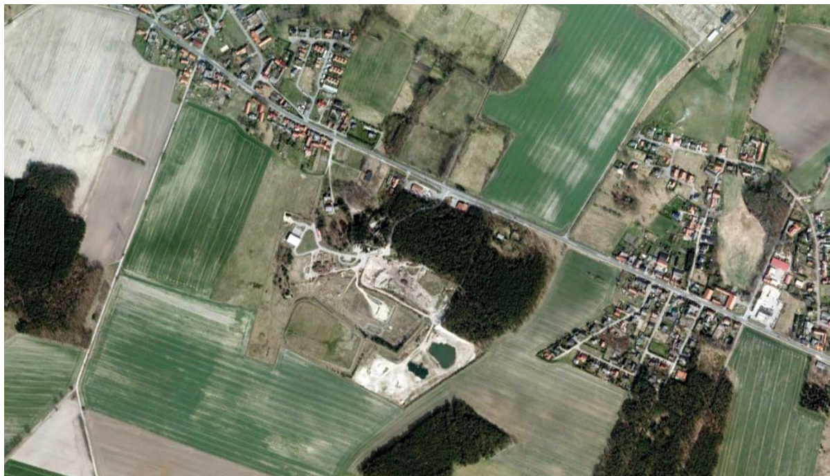
Figura 12 – Foto aerea dell'impianto
