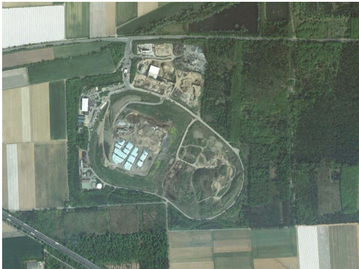
Figura 20 – Foto aerea dell'impianto
