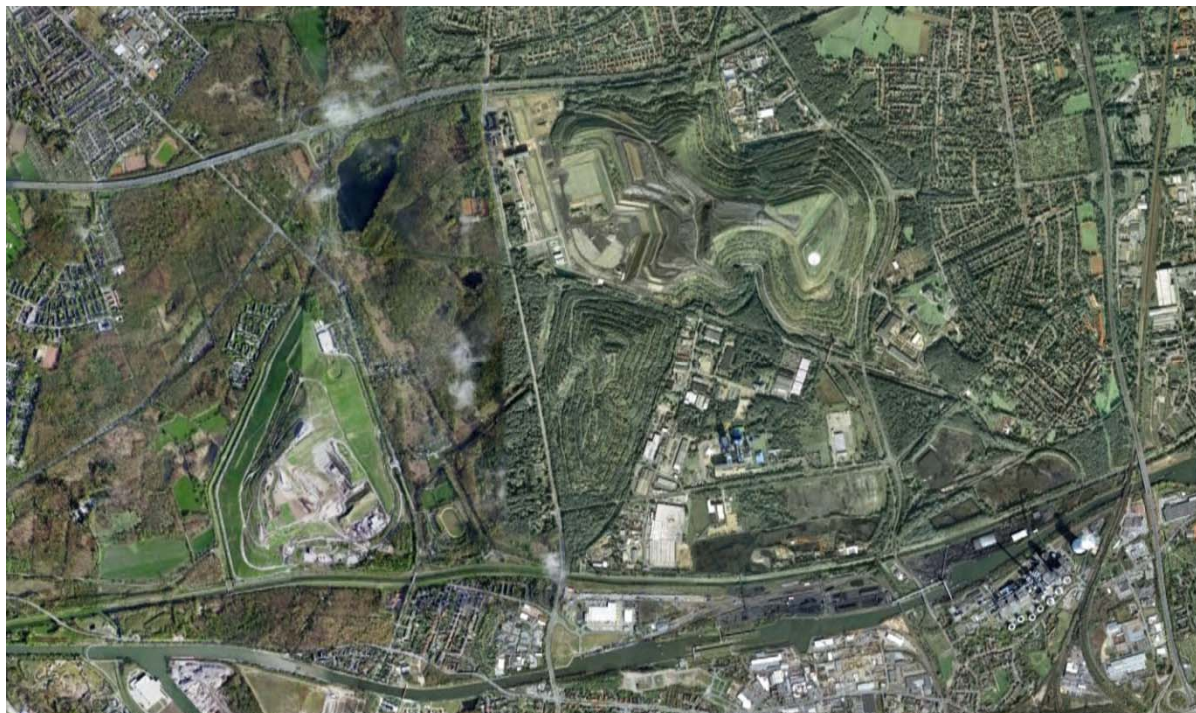
Figura 9 – Foto aerea dell'impianto
