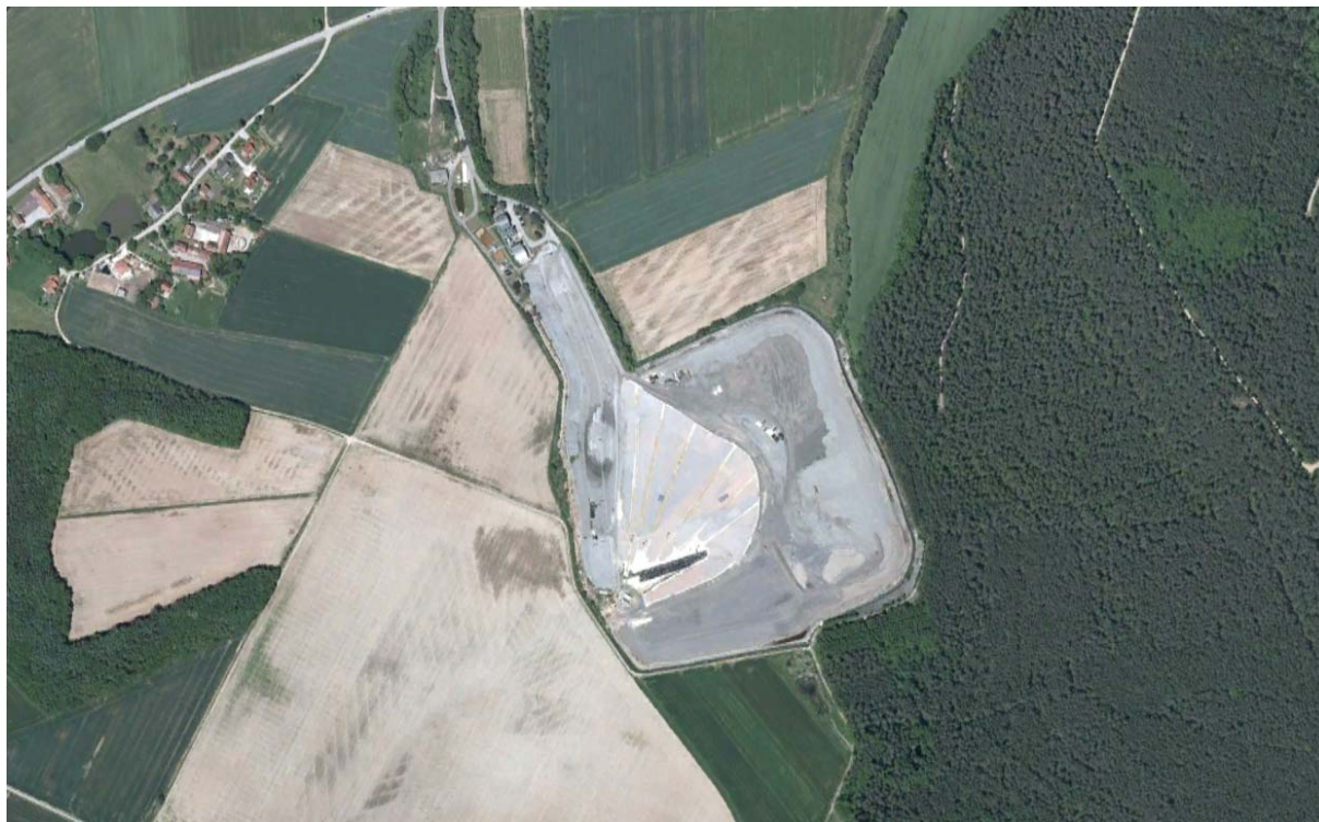
Figura 17 – Foto aerea dell'impianto
