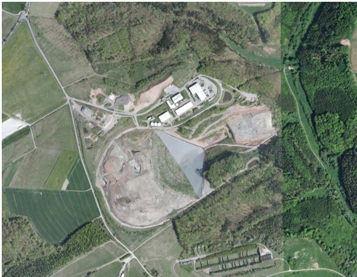
Figura 18 – Foto aerea dell'impianto
