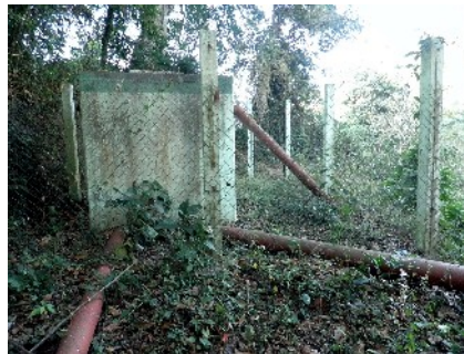
Intubazione del fiume Copalita.
