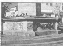
Auch der Hopfenbrunnen in der Innenstadt wartet beschmiert. Der Schaden beläuft sich auf etwa 10.000 Euro
